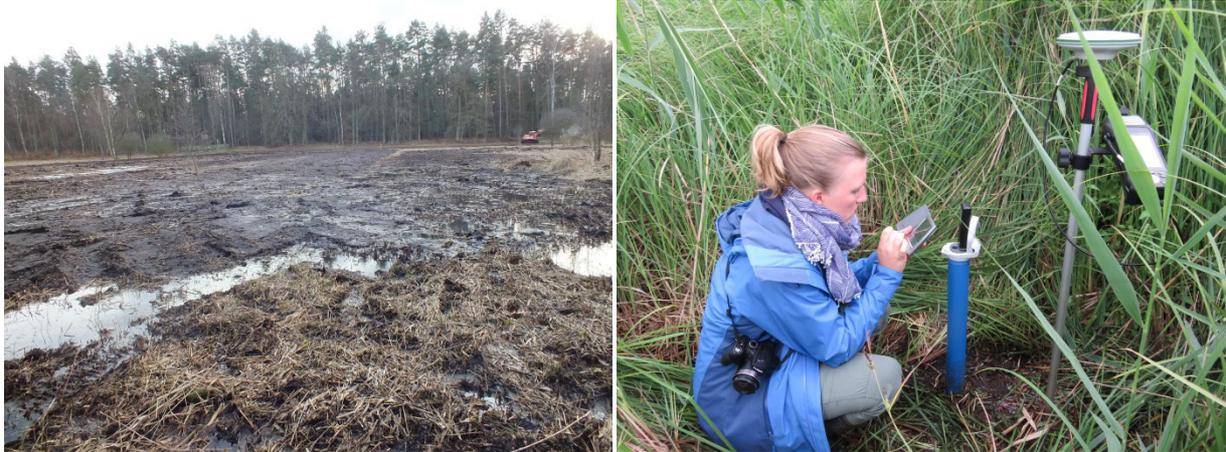
**Abbildung 26:** Bild links; Bereich der verfüllten Stichgräben während der Baumaßnahmen (Foto: F. Grübler 2013), Bild rechts: Installation und Einmessung des Grundwasserpegels (Foto: N. Hirsch 2018)
