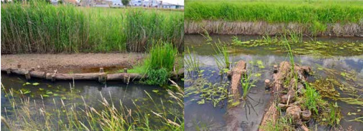
Abbildung 54: Bild links; Stammholz- und Raubaumbühne an der Straßenbrücke Doberlug (km 18,1), Bild rechts; Raubaumbühne unterhalb der Straßenbrücke Doberlug (km 18,15) (Fotos: K. Heinemann 2014)
