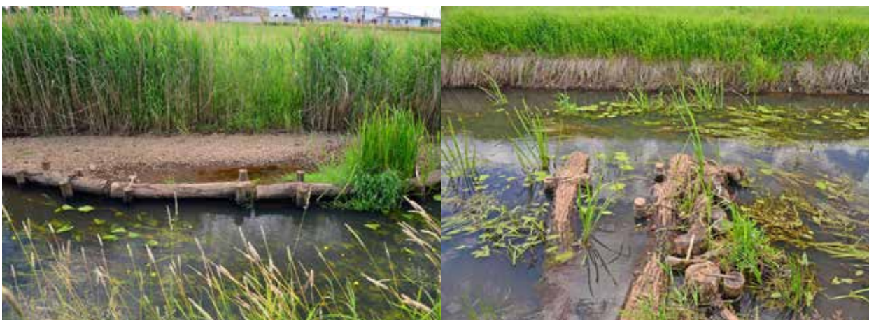
Abbildung 23: links: Stammholzbohrung an der Straßenbrücke Doberlug (km 18,1), rechts: Rauhaumböschung unterhalb der Straßenbrücke Doberlug (km 18,15) (Fotos: K. Heinemann 2014)
