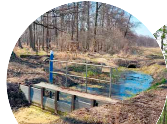
Der Probestau ermittelt die Stauhöhen, die für den Wald gut sind, aber noch eine landwirtschaftliche Nutzung möglich machen.
